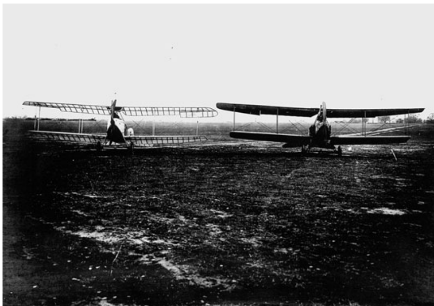
Abbildung 7. Ein mit Cellon-Bespannung fast unsichtbares Kriegsflugzeug neben einem Flieger mit Stoffbespannung. Das „durchsichtige Luftfahrzeug, gekennzeichnet durch einen wetterbeständigen Überzug aus etwa 1/10 Zellulosederivat und 9/10 Kampferersatz- und Gelatinierungsmittel“ wurde im Ersten Weltkrieg patentiert, blieb aber eine technische Utopie. Foto: Bayer-Archiv, Leverkusen.
