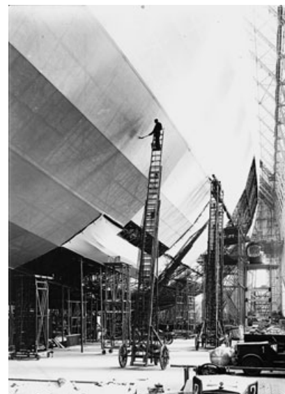
Abbildung 6. Mehrfaches „Cellonieren“ einer Zeppelinbespannung mit Eichengrüns Celluloseacetatlacken machte die Zeppeline gasdicht, windschlüpfig und witterungsbeständig. Foto: Archiv für Luftschiffbau Zeppelin GmbH, Friedrichshafen.
